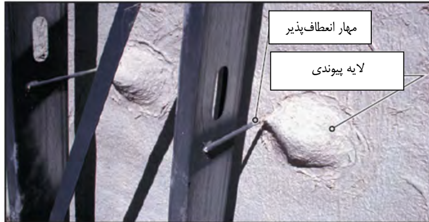
شکل ۶-۳۸- لایه پیوندی و مهارهای انعطاف‌پذیر
