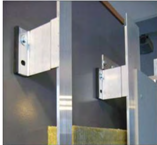
شکل ۶-۴۵- نمونه‌های زیرقاب ساخته‌شده با قطعات آلومینیومی
