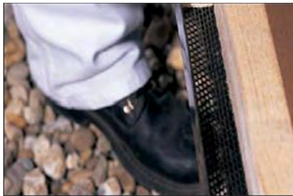
شکل ۶-۶۱- اجرای شبکه توری زیر دیوار
