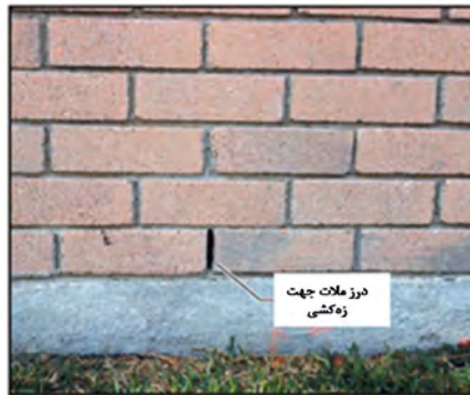
شکل ۵-۱۵- خالی گذاشتن درز ملات جهت زه‌کشی
