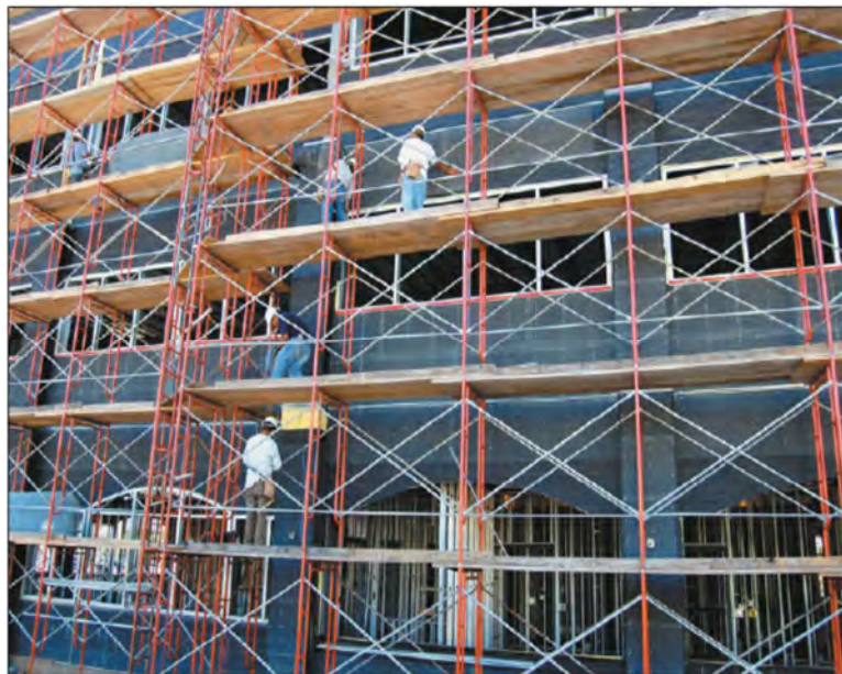
شکل ۶-۳- نمای یک ساختمان ۵ طبقه پوشانده شده با استفاده از داربست به منظور اجرای نمای سیمانی
