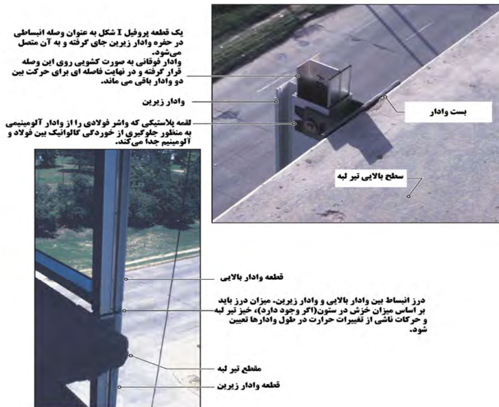
شکل ۸-۸- نمونه اتصال انبساطی بین دو قطعه وادار
