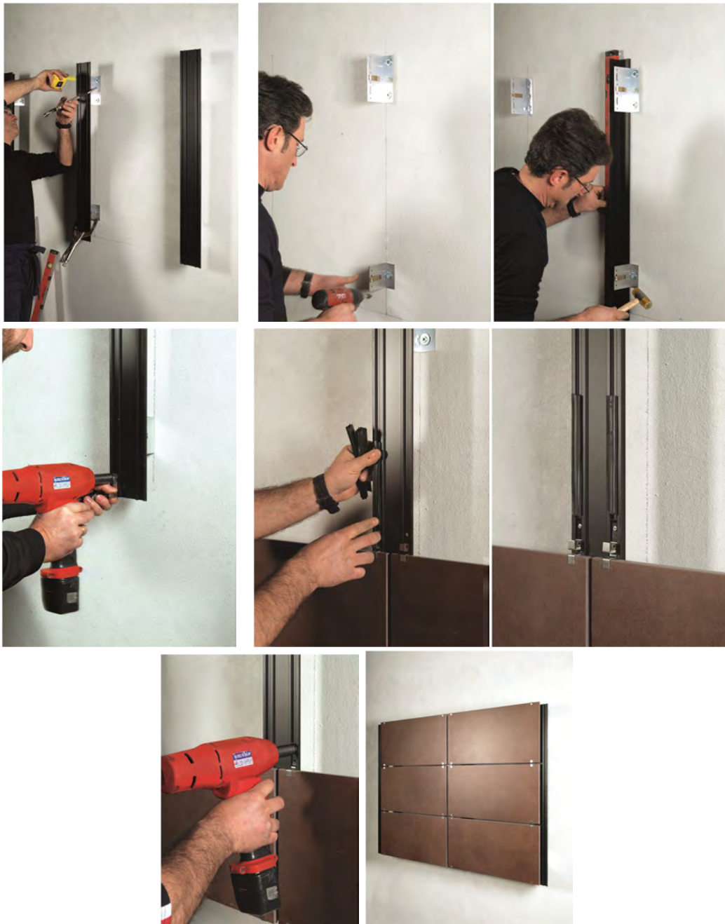
شکل ۷-۲۴- مراحل نصب سیستم نصب نمایان
