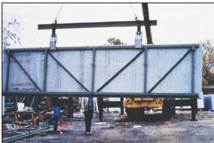
شکل ۴-۲۵- پانل دیواری پرده‌ای پیش‌ساخته سنگی
