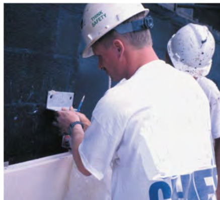
شکل ۴-۶ - بست‌های نبشی J شکل مهار شده به دیوار پشتیبان بلوک سیمانی و یا بتنی
