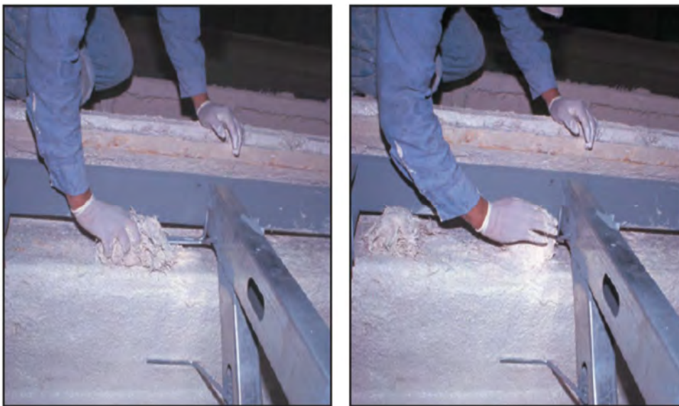
شکل ۶-۴۳- ساختن لایه‌های پیوندی
