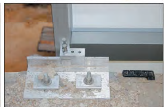
مهر یکی از قطعات نما به سازه بوسیله بست های بار ثقلی
