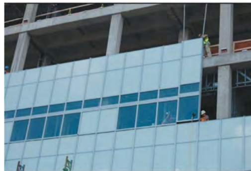
قطعه جدید با اتصال وادارهای قطعه فوقانی به وصله های قطعه پایینی نصب می شود. این وصله ها جهت توسعه نما و همچنین ایجاد مقاومت در برابر بار جانبی کاربرد دارند.
