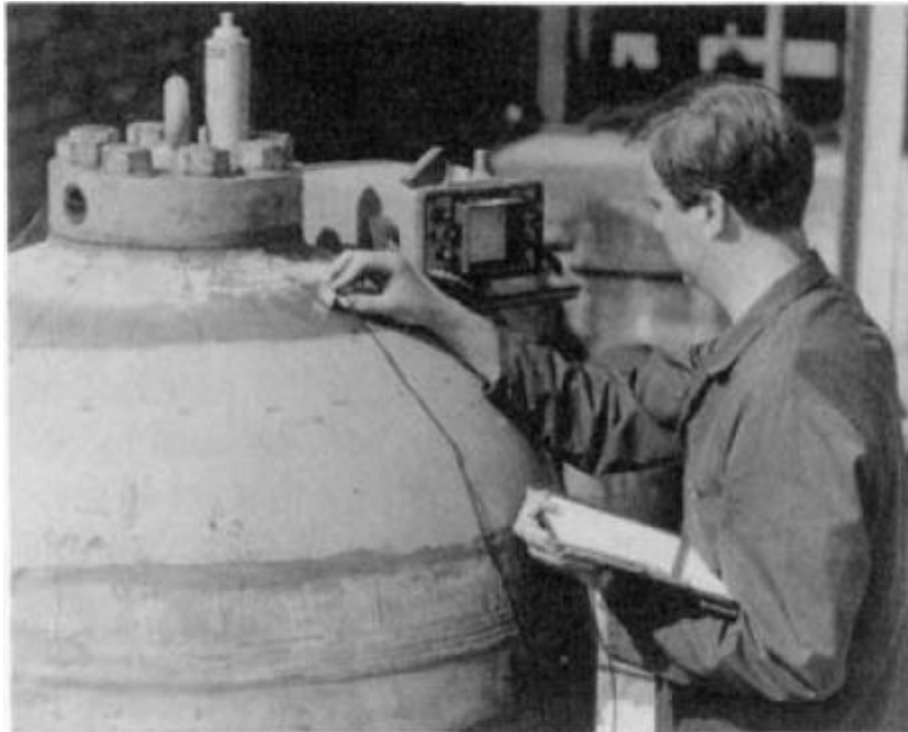
شکل 19- آزمون UT روی نازل یک مخزن.
